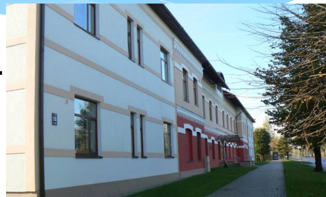
Renovētais Valmieras pilsētas pansjonāts "Valmiera"
